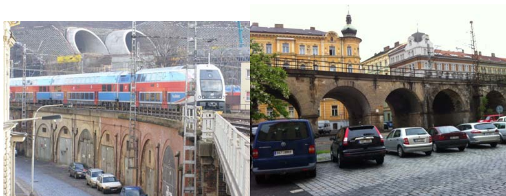
Negrelli viaduct (Karlin viaduct) today
